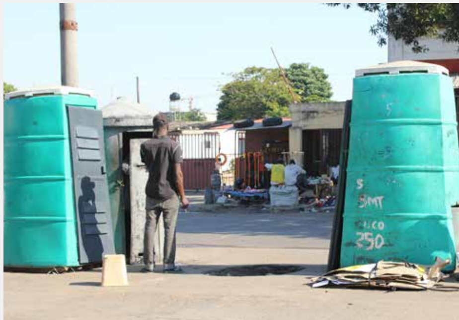
Os sanitários públicos não têm estado a cumprir a missão para a qual foram instalados
